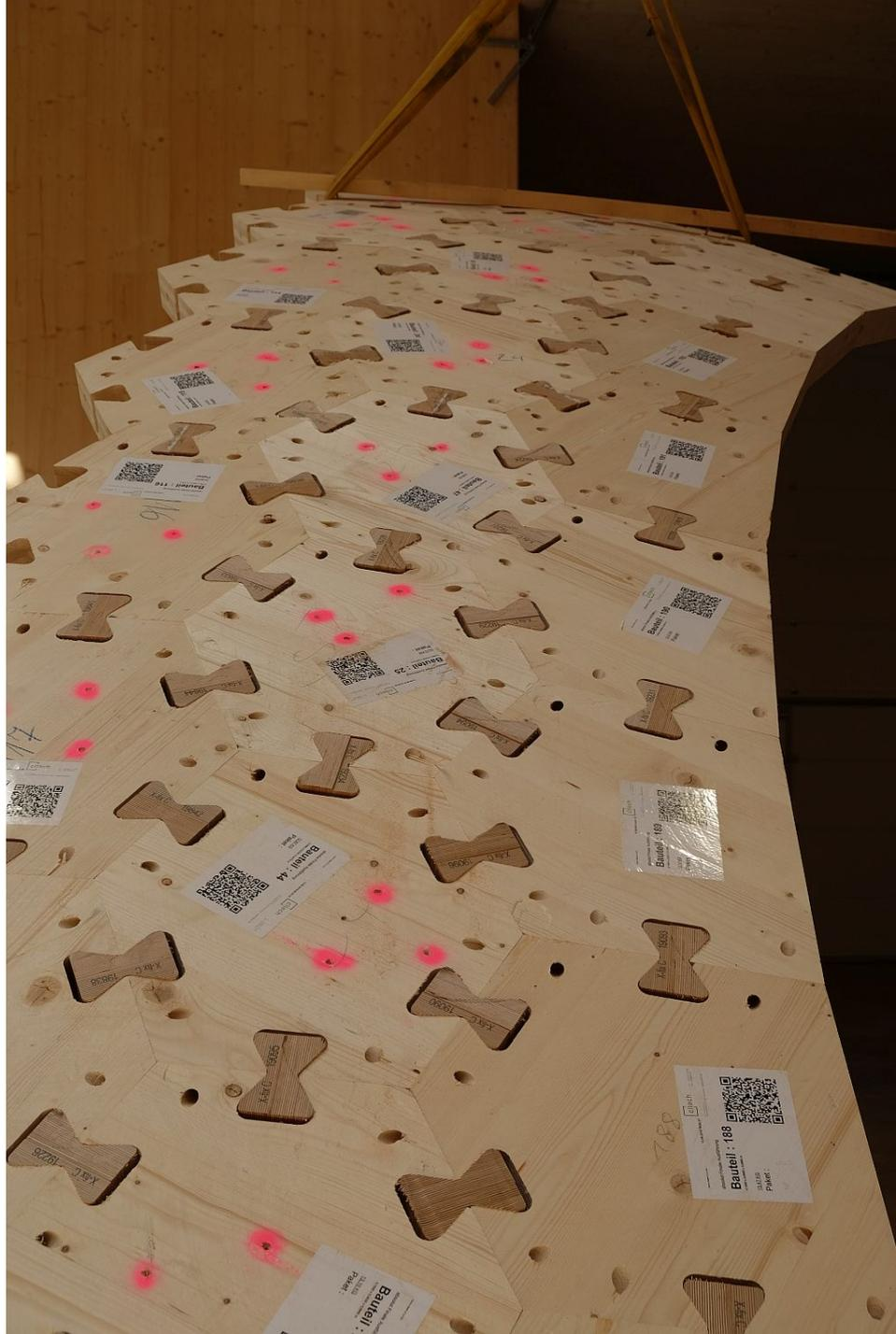
Die X-Fix-Verbind器 sorgen bei der Montage für ein passgenaues Zusammenziehen und Fixieren der Schale
